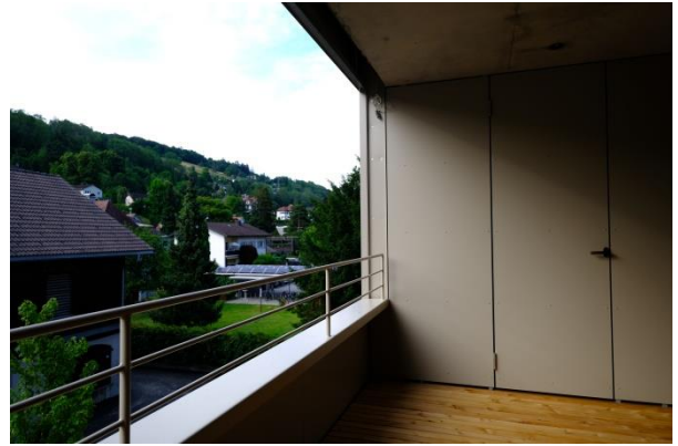
Loggia mit Abstellraum
