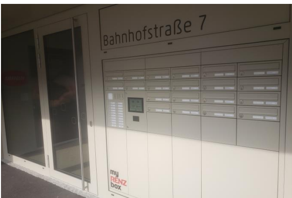
Eingangsbereich mit elektronischer Paketbox
