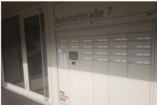
Eingangsbereich mit elektronischer Paketbox
